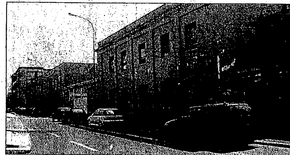
Il fatiscante immobile dell'ex Cidneo in via Chiusure: verrà demolito
